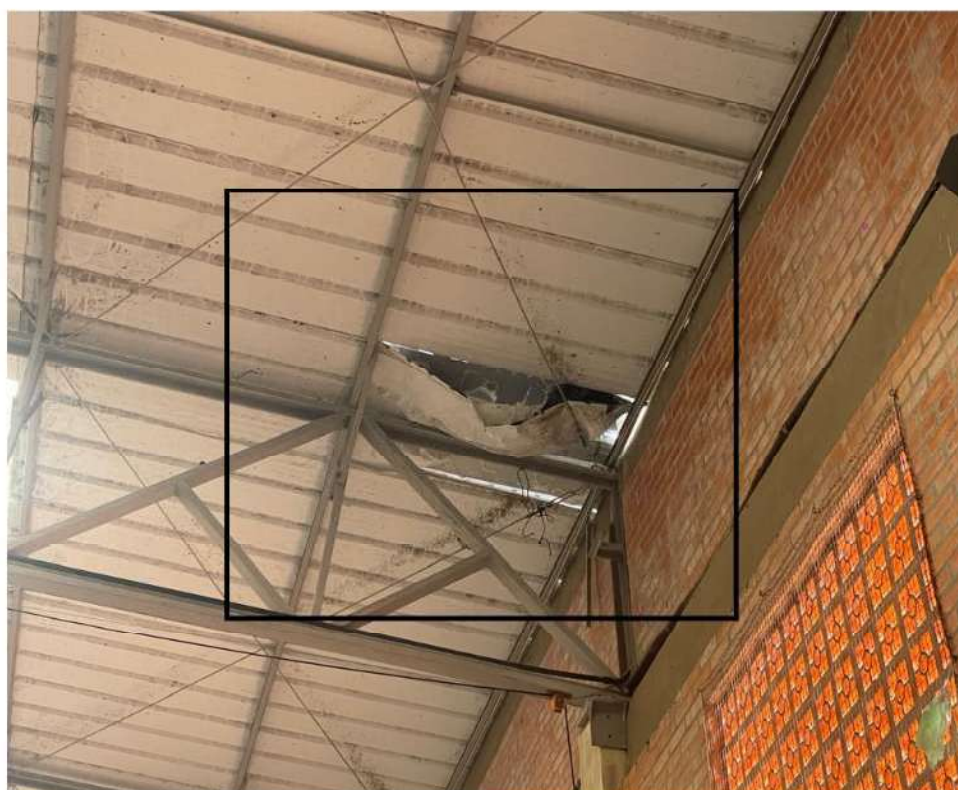
Figura 02 - Telha quebrada
