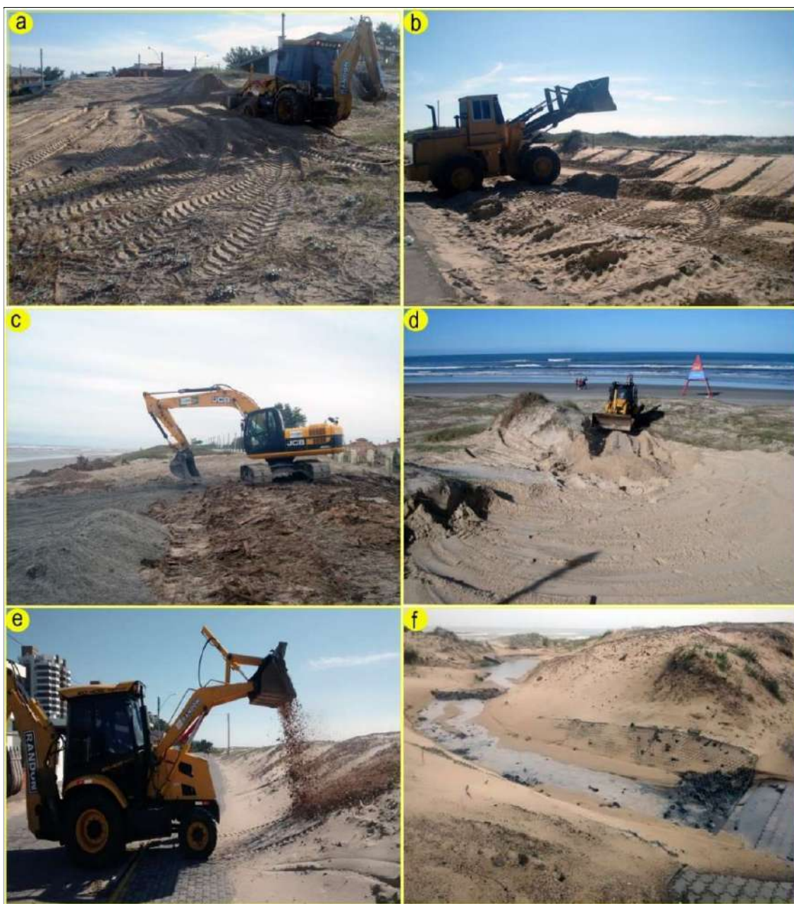
Figura 2.5- Principais ações na modelagem e estabilização das dunas e redimensionamento de drenagens com o emprego de máquinas: a) rebaixamento das cotas e suavização das rampas, a barlavento; b) corte e raspagem do talude reverso do segundo cordão de duna na interface com a Avenida Beira Mar; c) preenchimento e construção de dunas por meio do uso de areia oriundas do trabalho de suavização dos taludes; d) controle dos fluxos de velocidade de ventos incidindo sobre os nódulos remanescentes de dunas; e) espalhamento de cobertura morta sobre a superfície livre da duna; f) abertura de canais de drenagens na desembocadura de ruas acoplados a sistema de colchões Reno - lagoas de estabilização entre dunas.
